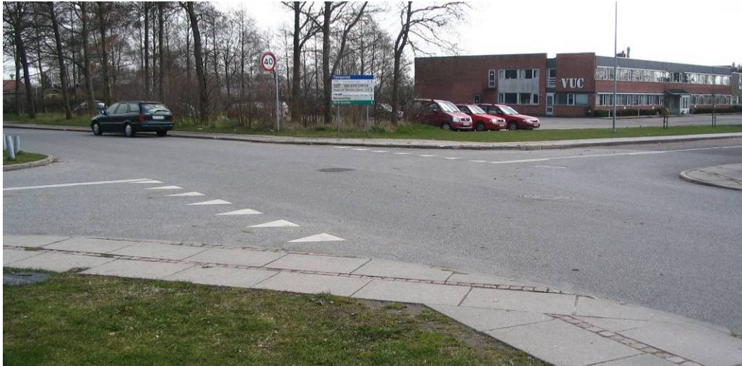
Kryds ved Hadsund Hallerne er utilgængeligt for synshandicappede.
