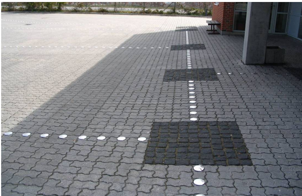
Særlige ledelinier på Hadsund Rutebilstation. Disse er dog ikke udført efter anbefalingerne.
