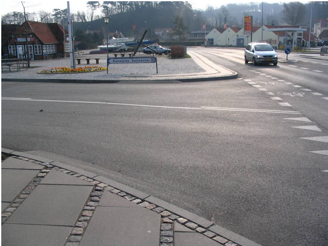
Fodgængere krydser i dag bag vigepligtslinien. Ramperne på begge sider er for stejle.
