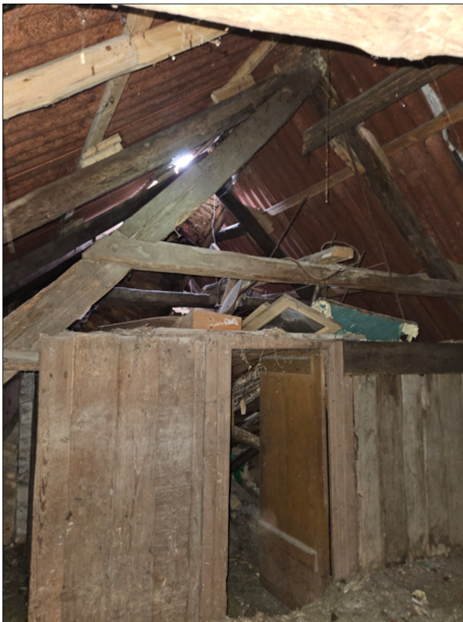
Figur 17. Loftrummet med typiske hanebåndsspær i Adelgade 45.
