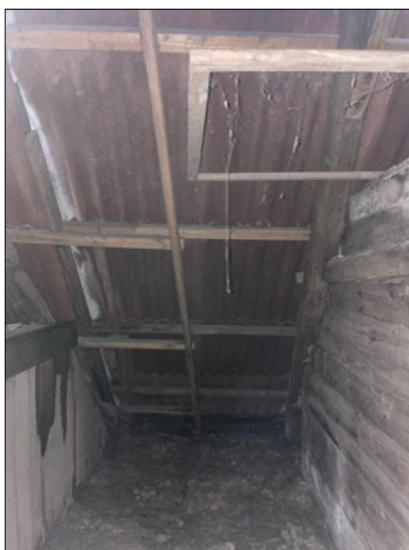
Figur 21. Adelgade 45. Uisoleret loftrum
