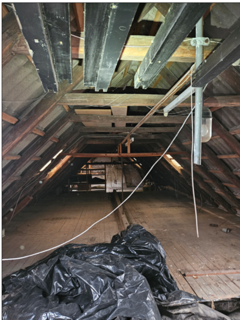
Figur 22. Loftrum i bygning beliggende mellem Adelgade 43 og Nytorv 12 med typiske hanebåndsspær.
