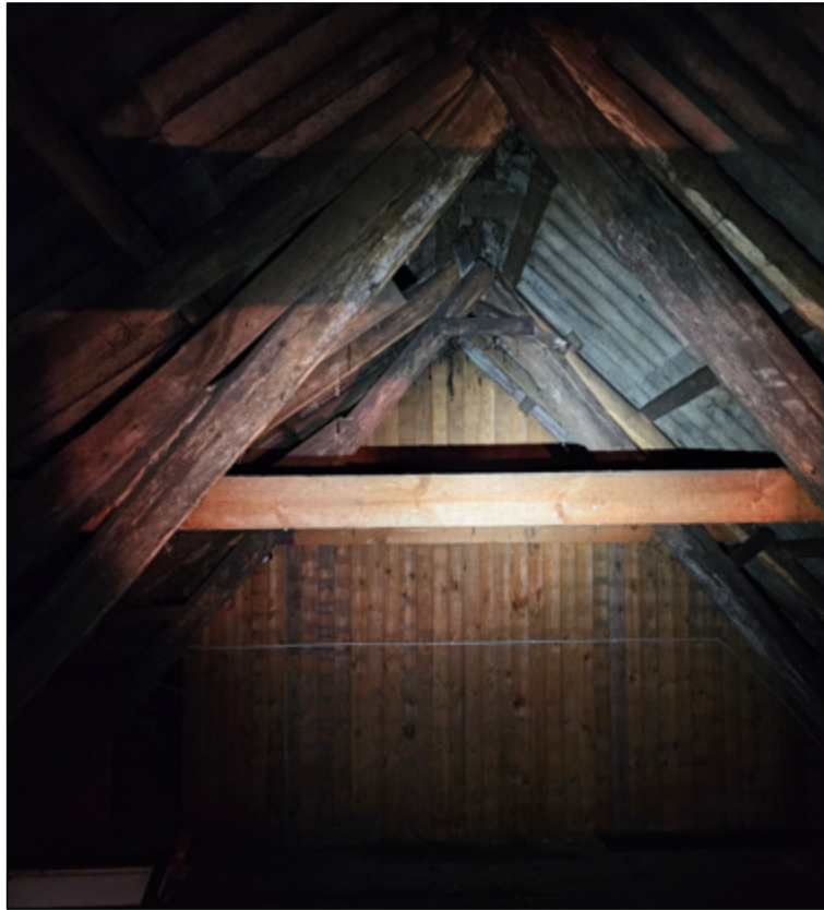
Figur 9. Loftrummet med typiske hanebåndsspær i bygningen på adressen Adelgade 43.
