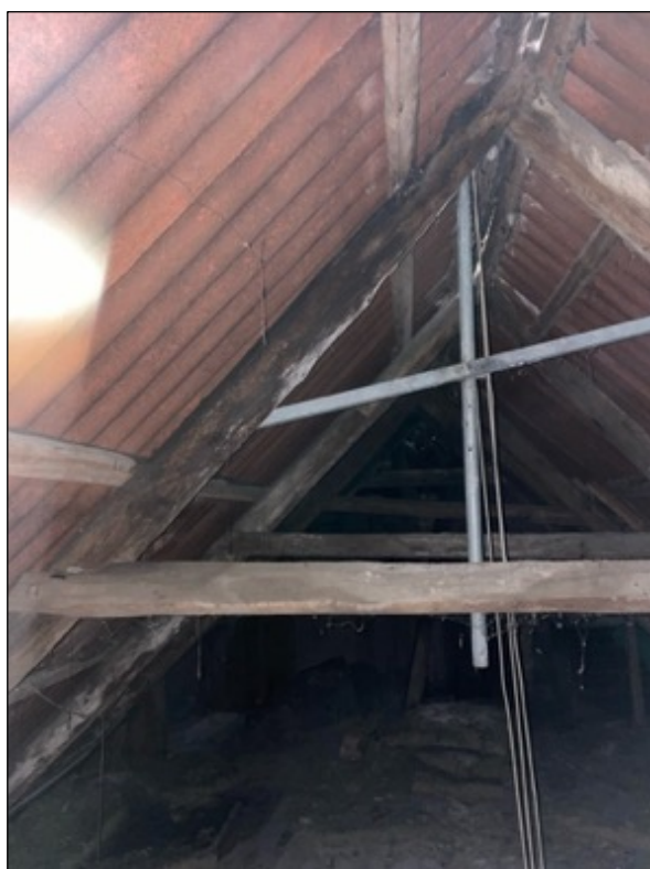
Figur 20. Adelgade 45. Uisoleret loftrum med typiske hanebåndsspær
