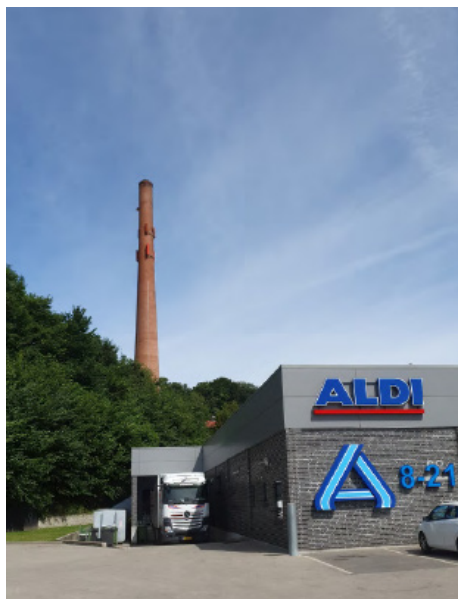
Eksisterende skorsten ved Hobro varmeværk
