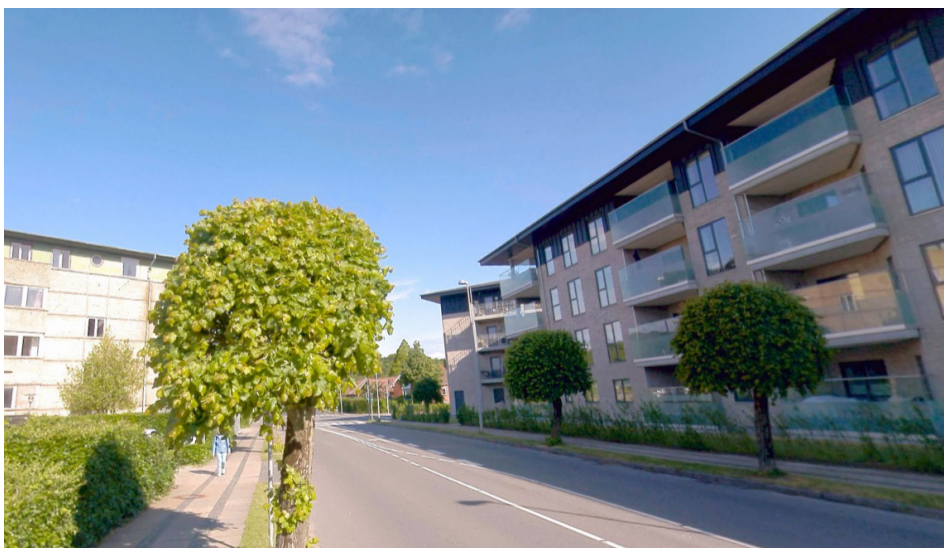
Fig. 67: Nabobebyggelse mod nord ses til højre i billedet. Eksisterende bygning i planområdet der skal nedrives ses til venstre i billedet [Cowi Gadefoto, 2024]
