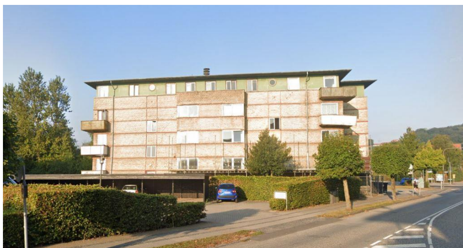
Figur 2 Eksisterende bygning til beboelse på Jernbanegade 15A-B.
