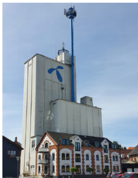
Eksisterende silo i Skibsgade
