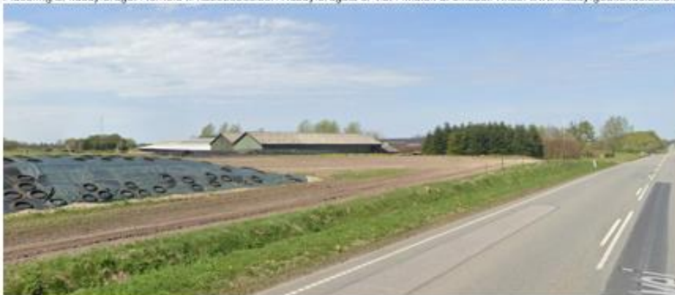
Billede taget fra Hobrovej i nordlig retning ind mod husdyrbruget. I forgrunden ses en markstak. Mellem markstakken og bygningerne er ensilageopbevaringsanlægget placeret. Kilde: Google Maps, streetview.google.com .
