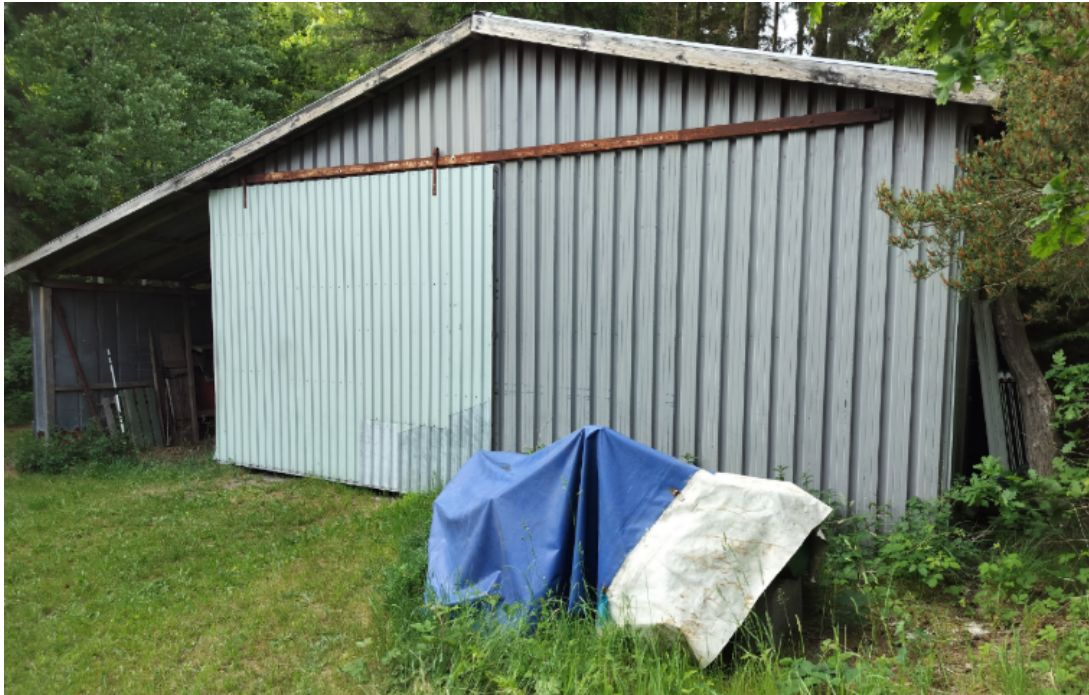
Figur 3 Maskinhus set fra syd mod nord
