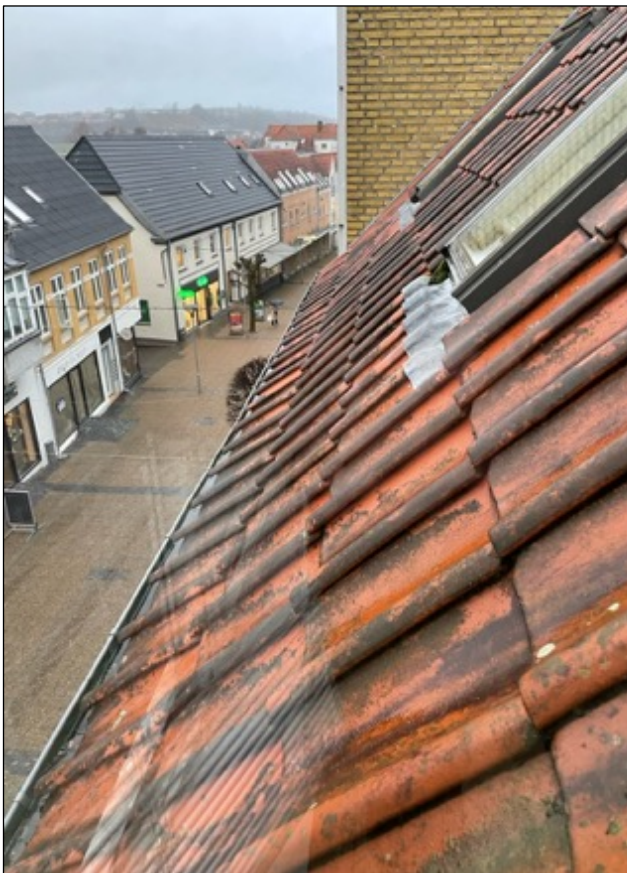
Figur 5. Adelgade 41. Skunken mod nordvest
