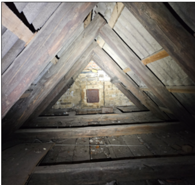
Figur 25. Hulrum over de to rum med hanebåndsspær
