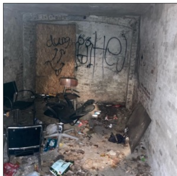
Figur 16. Kælder under Skibsgade 1
