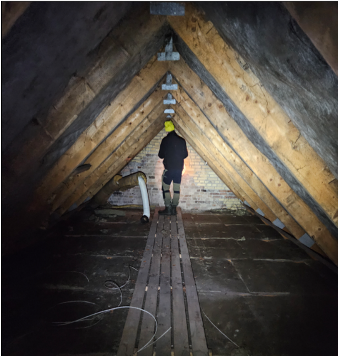
Figur 2. Loftrummet i bygningen på adressen Adelgade 41.
