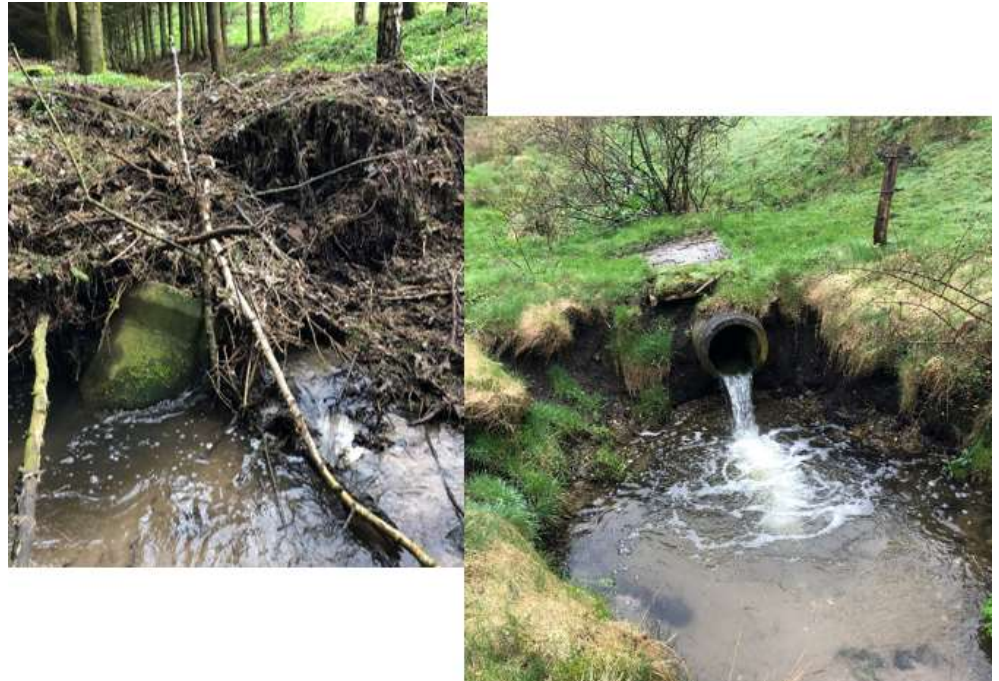
Figur 5 To observerede spærringer i Oue Bæk. Til venstre ses udløbet af den sammenstyrtede overkørsel ved AAL-8124 og til højre en røroverkørsel med styrt, hvor der ikke er udpeget en indsats i vandområdeplanerne.
