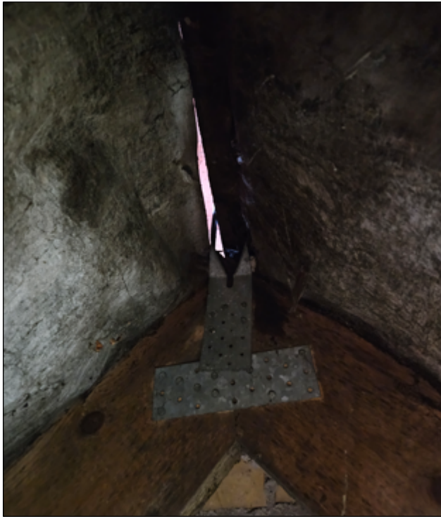
Figur 3. Åbning i bygningens gavl.
