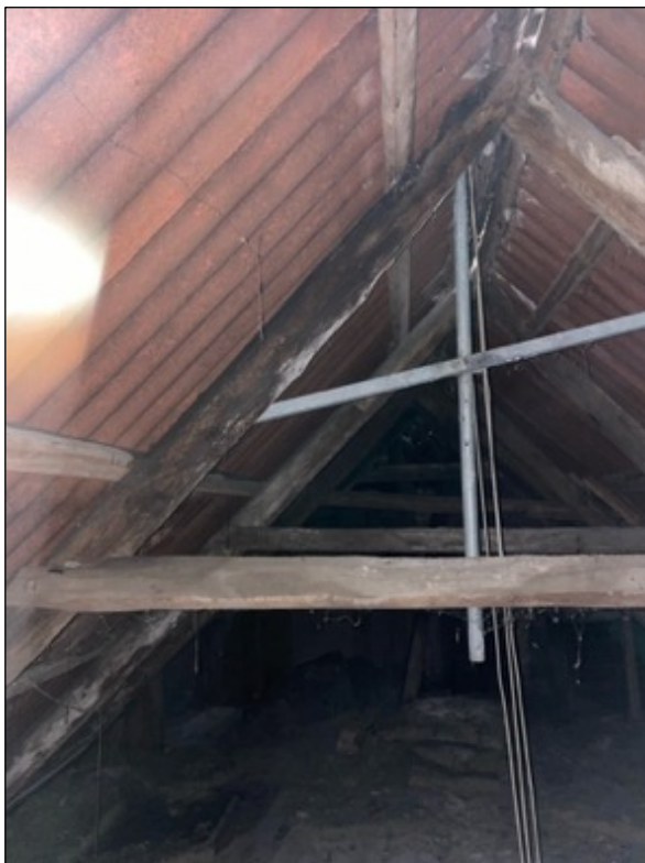
Figur 20. Adelgade 45. Uisoleret loftrum med typiske hanebåndsspær
