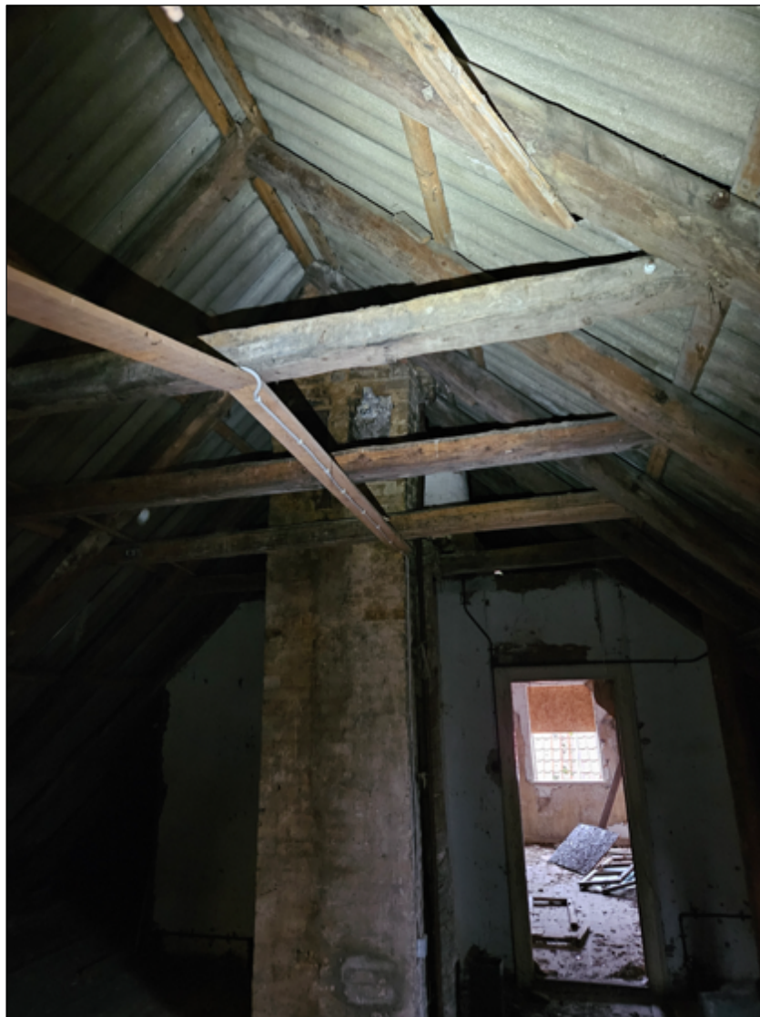
Figur 28. Lofttrummet i bygningen på Skibsgade 3 med hanebåndsspær.
