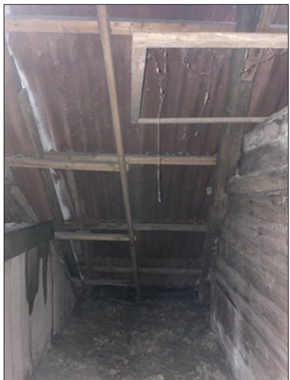
Figur 21. Adelgade 45. Uisoleret loftrum
