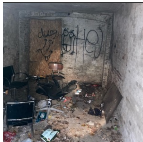
Figur 16. Kælder under Skibsgade 1
