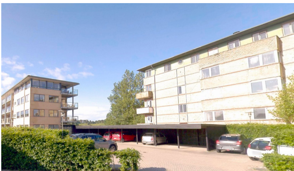
Fig. 66: Nabobebyggelse mod øst ses til venstre i billedet. Eksisterende bygning i planområdet der skal nedrives ses til højre i billedet [Cowi Gadefoto, 2024]
