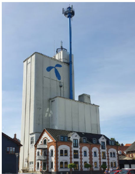
Eksisterende silo i Skibsgade
