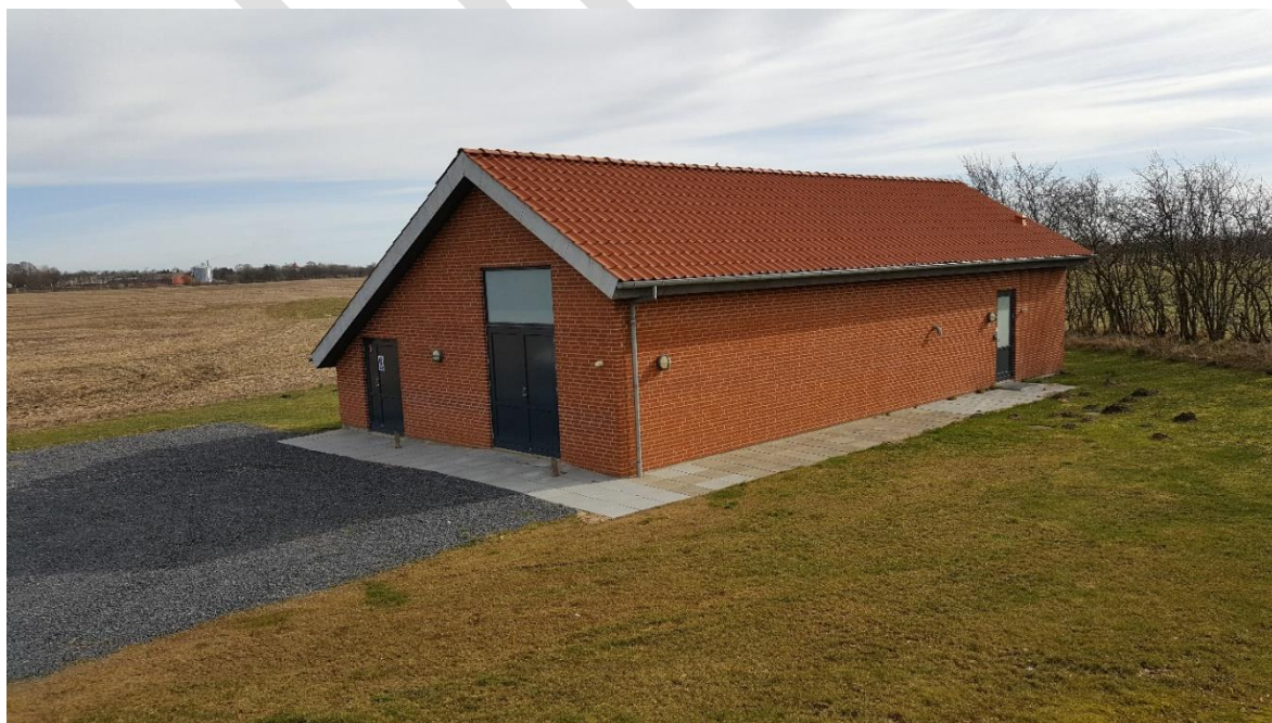
Foto: Skjellerup Vandværk
