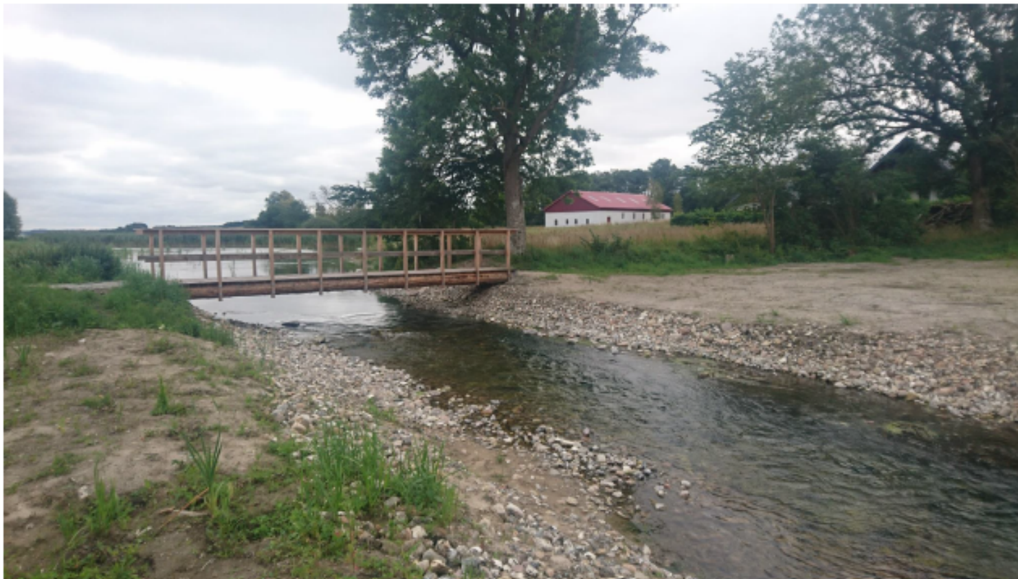
Billedet viser det nye afløb fra søen ultimo 2017.
